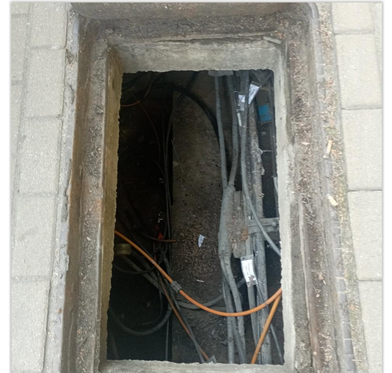
Prace polegały na wykonaniu napraw w mufie. Stan po pracy – mufa niewidoczna, fotografia niepoprawna.
