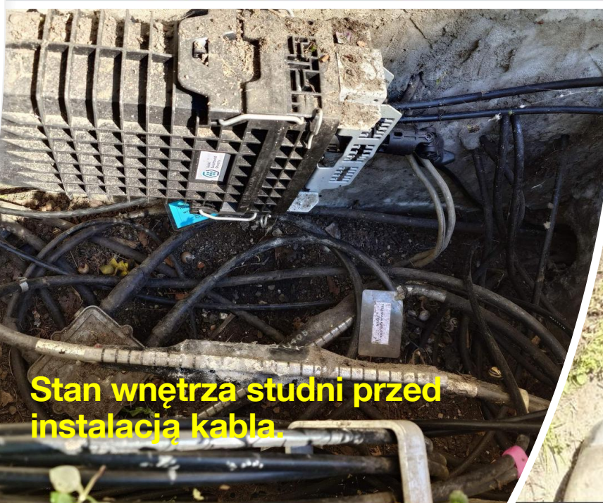
Fotografia ukazuje stan studni i jej lokalizację.
