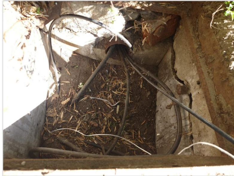
Stan studni przed pracą – fotografia prawidłowa.
